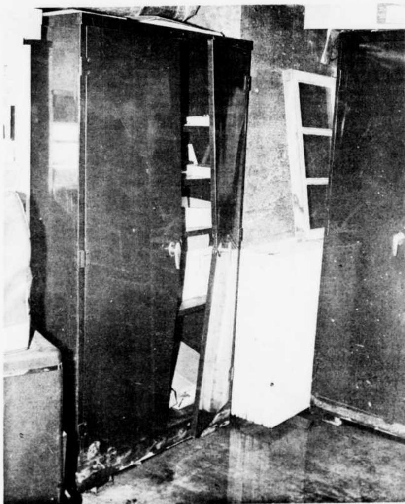
ARMOIRES D'ACIER ouvertes par effraction dans une pièce servant à entreposer du matériel de bureau, toujours au Roberval-Saguenay.
