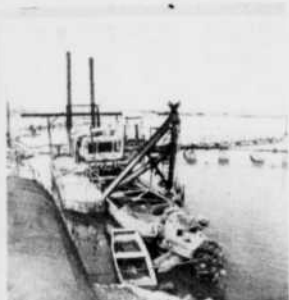
La drague, le remorqueur, l'usine de pompage
