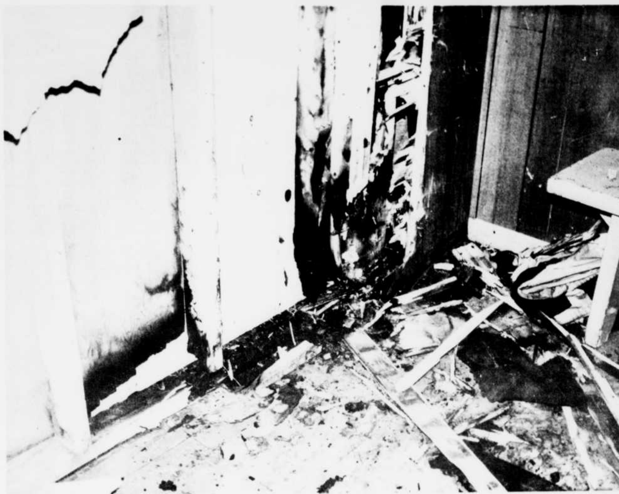
AU ROBERVAL-SAGUENAY, à Alma, la gare a subi des dommages par le feu, le vandalisme et le vol.
