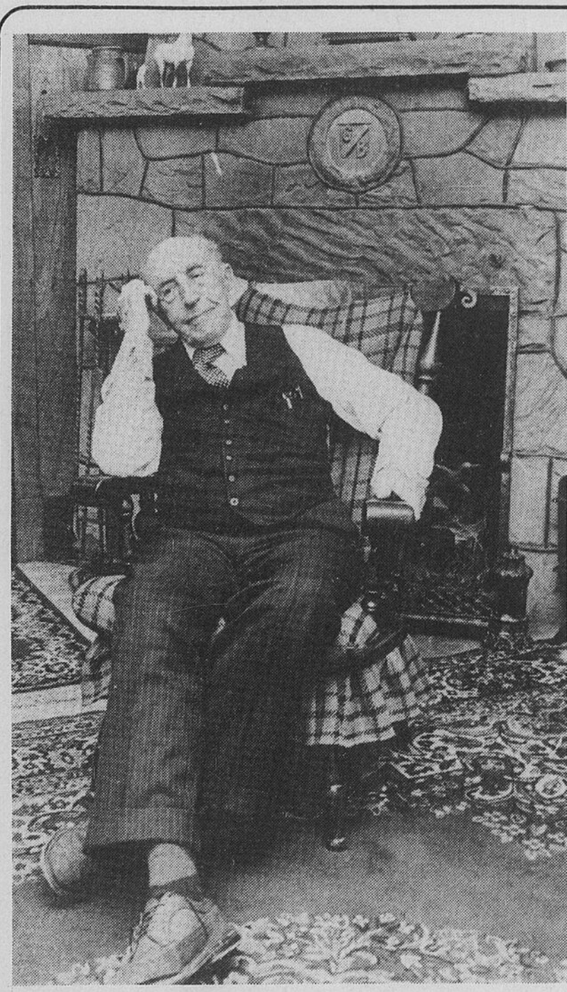
Un des ouvriers de la première heure, M. Gustave Brault.
