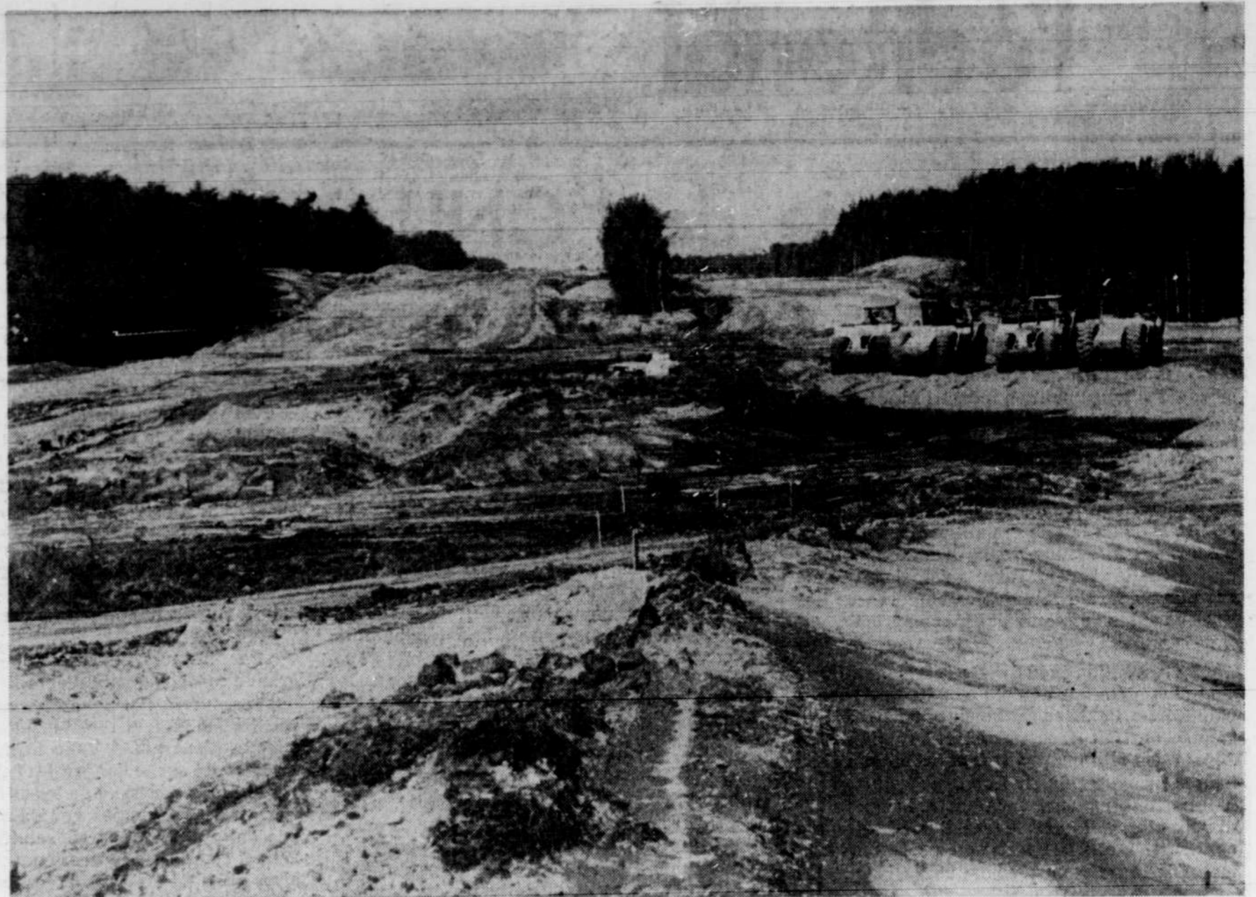
L'autoroute de la Beauce attend le pavage.
