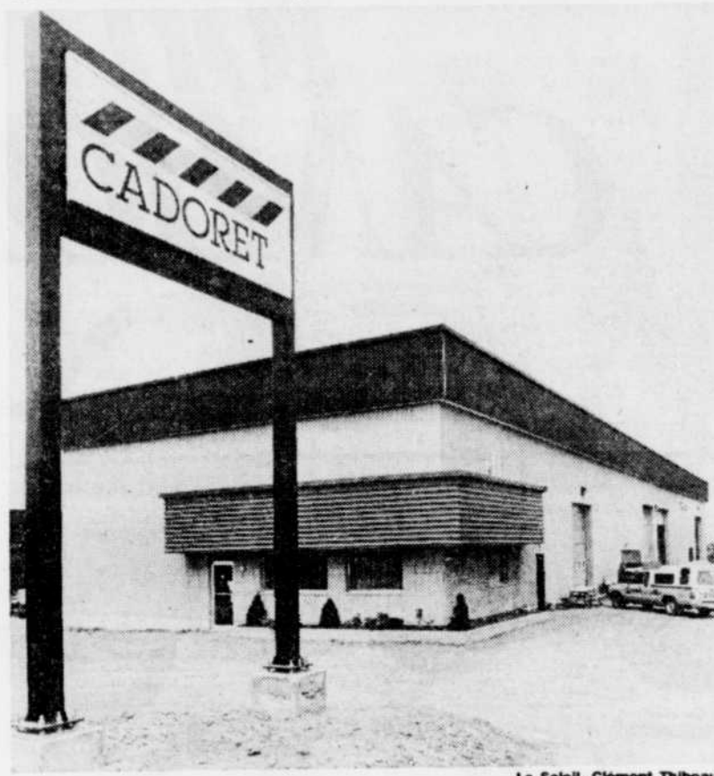
L'entreprise Cadoret, qui emploie 40 personnes, affiche depuis quatre ans une croissance supérieure à 35 pour 100.
