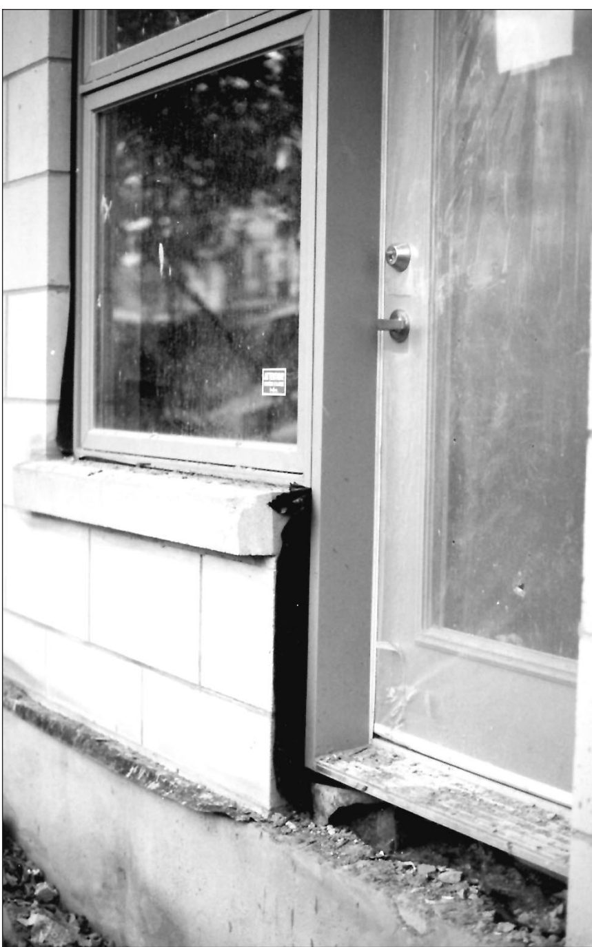
Les solins d'étanchéité bien installés entre les fenêtres et la maçonnerie permettent d'éviter de nombreux problèmes.
