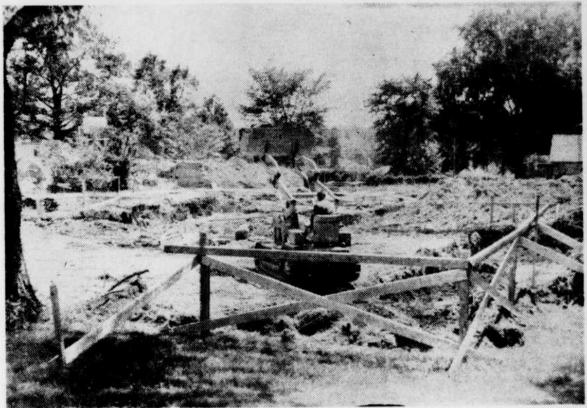
Travaux d'excavation pour le futur juniorat.
