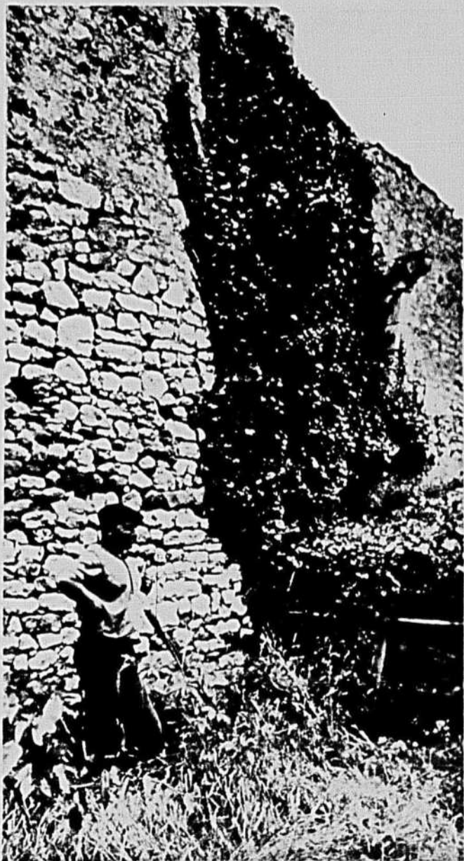
● À Brouage, en Saintonge, tout ce qui reste de la demeure de S. de Champlain: un pan de mur.
