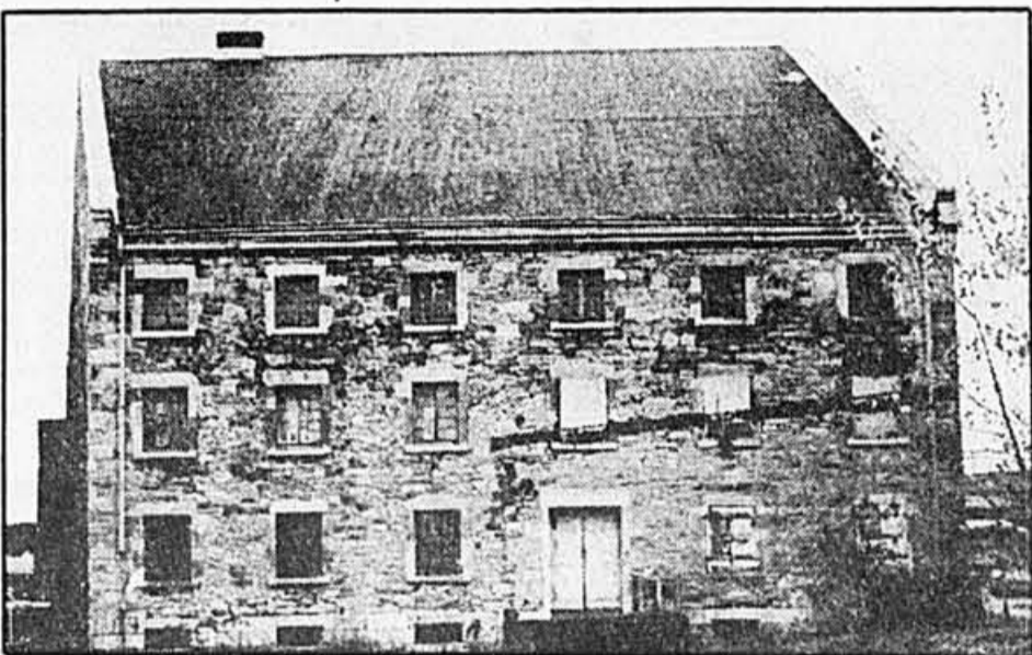
L'entrepôt Buchanan avant la restauration. On peut remarquer la ligne laissée par le toit de l'appentis depuis démolli.
