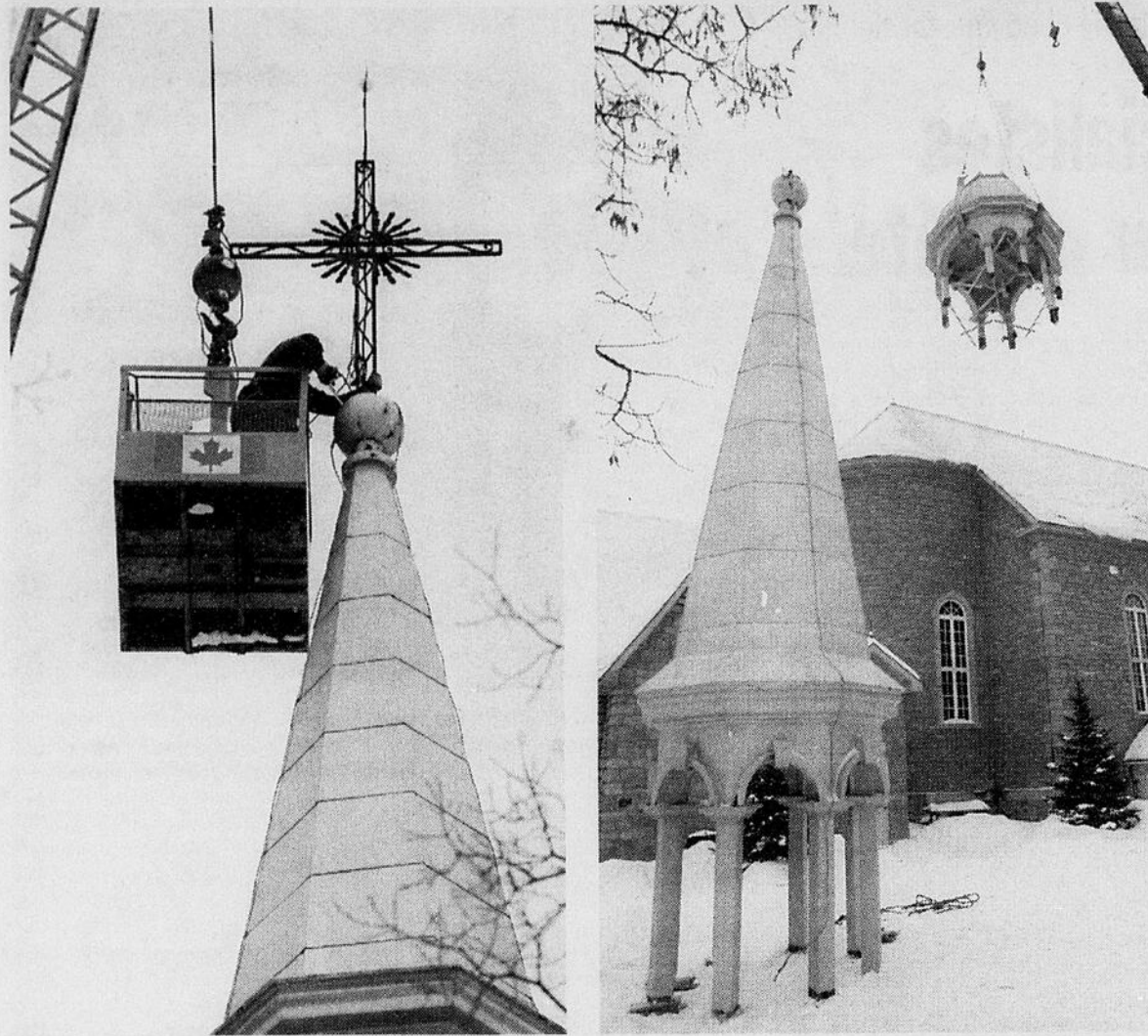
Le démontage du clocher a commencé par l'enlèvement de la croix. Les ouvriers ont dû scier la base d'acier qui la retenait au sommet de la pointe. Ont suivi la pointe elle-même et la chambre qui abritait la cloche.
