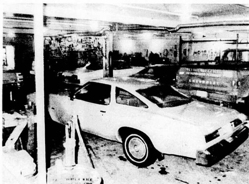
L'Atelier mécanique est des plus perfectionnée.
