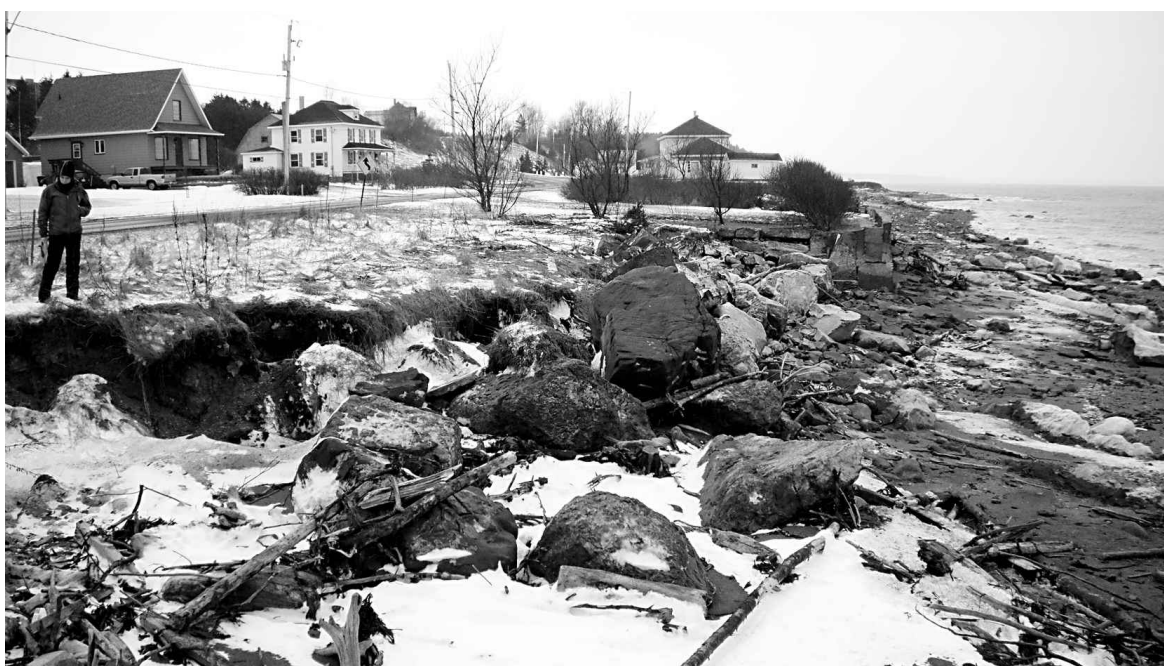
À la longue, un enrochement, même fait d'immenses pierres, peut être détruit par la force des vagues.
