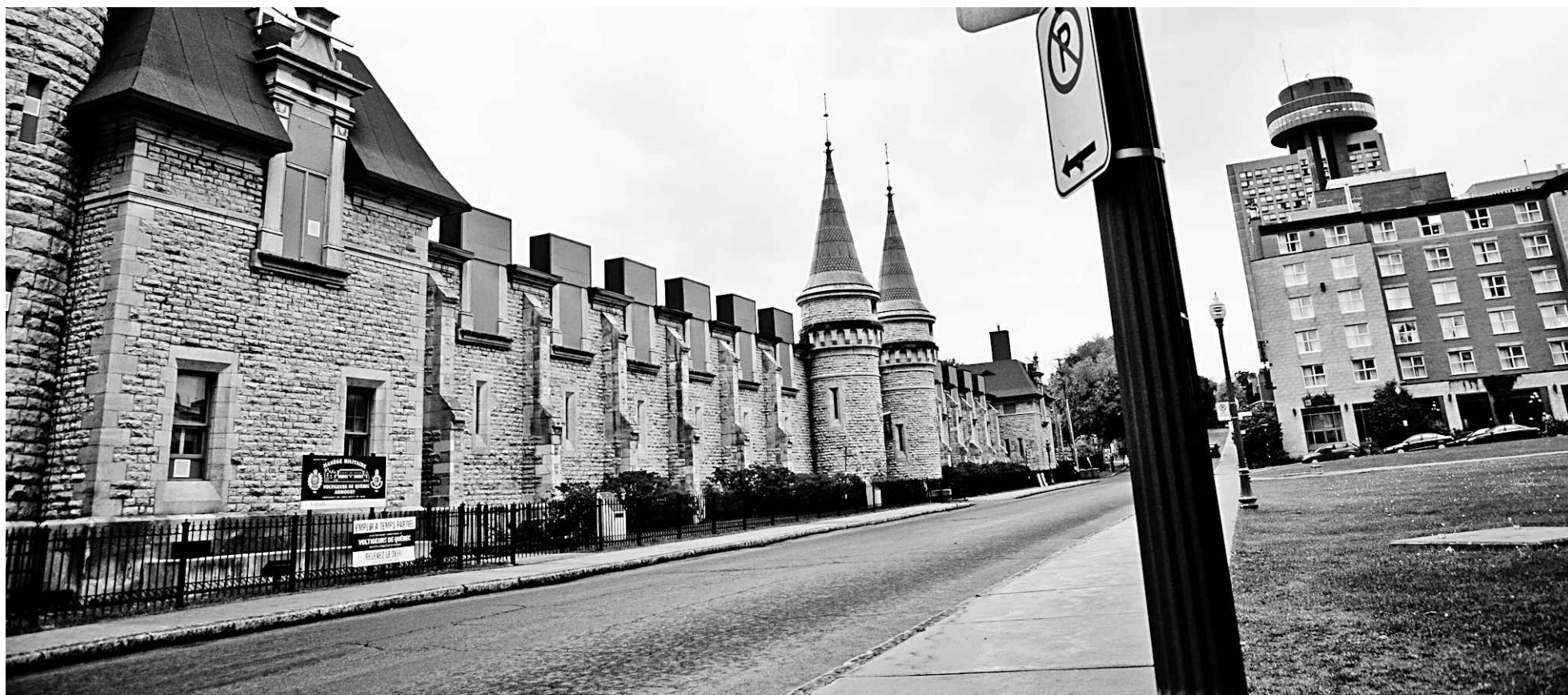
Le calendrier des travaux élaboré par le fédéral évoque le mois de mars 2016 comme limite ultime pour l'octroi du contrat de construction. — PHOTOTHÈQUE LE SOLEIL, RENAUD PHILIPPE
