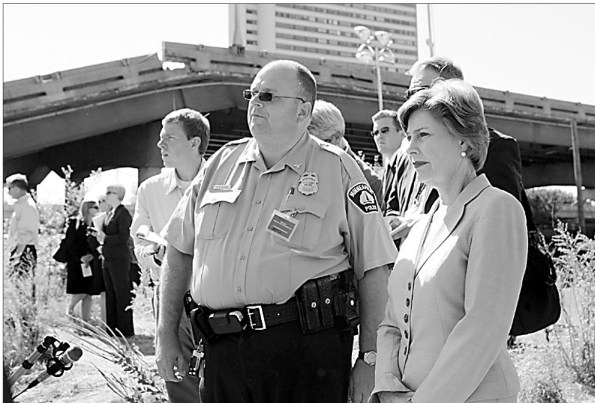
La première dame des États-Unis, Laura Bush, a visité les lieux de l'effondrement du pont à Minneapolis survenu mercredi dernier en pleine heure de pointe. Ce sera au tour de George W. Bush de constater les dégâts aujourd'hui.
