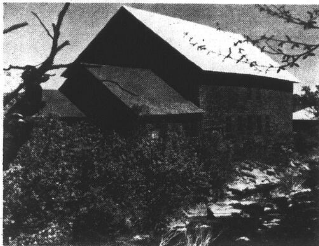
Le moulin à eau plus que centenaire, du petit village de Sainte-Aurélie, dans la Beauce.
