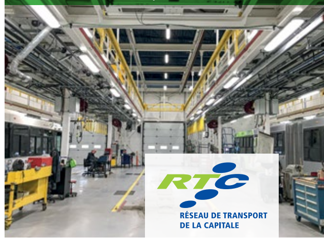
Aménagement d'une mezzanine permettant de travailler à hauteur de toit des autobus hybrides.
