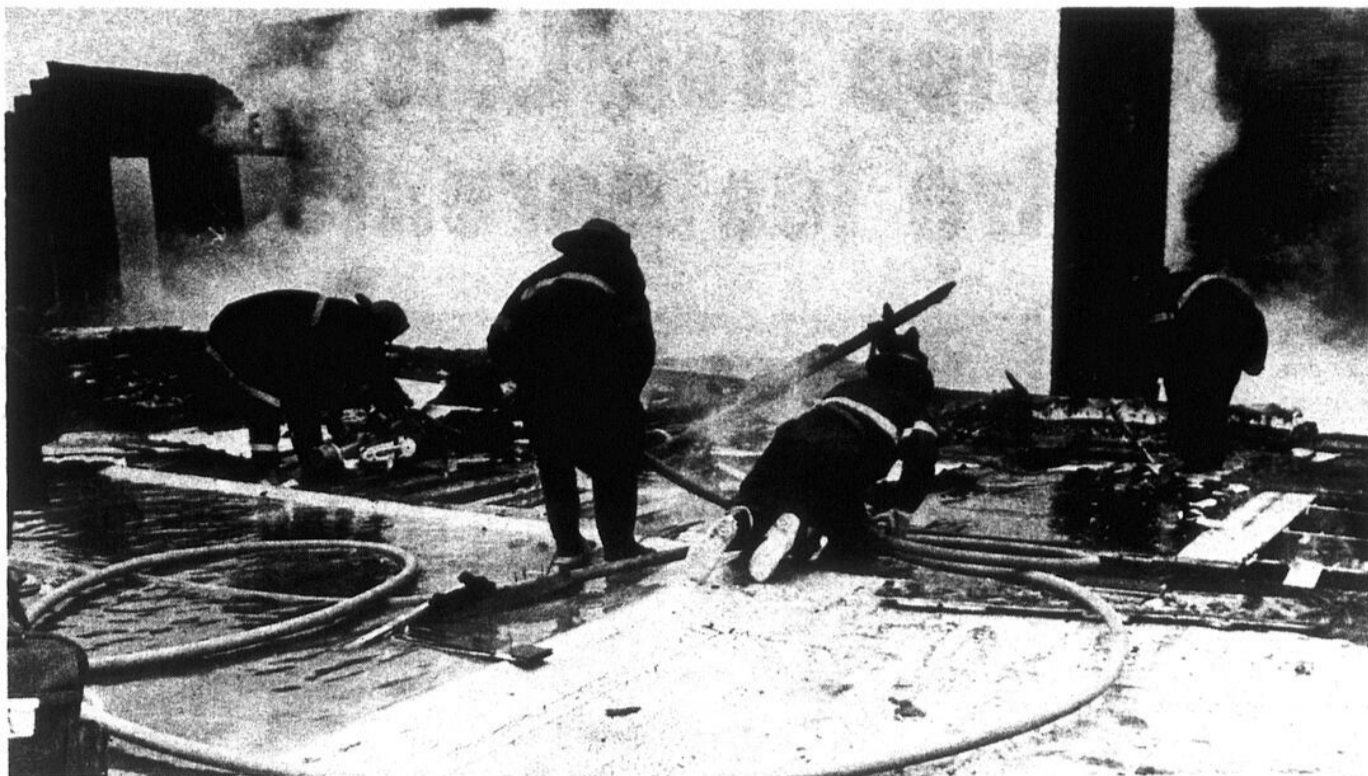
Pour faire en sorte que l'incendie ne se propage pas à un autre édifice, les sapeurs, à l'aide de scies mécaniques, ont percé la toiture au-dessus du magasin Royaume des jouets.
