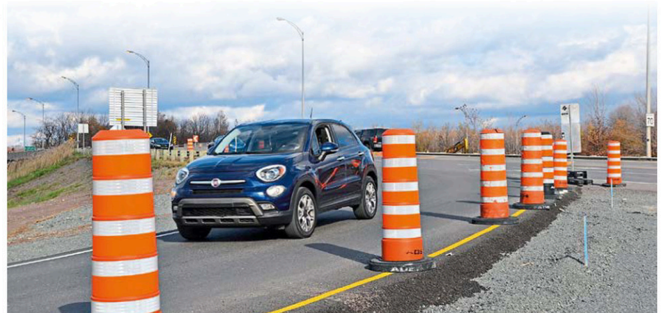
Parmi les travaux faits cette année, notons l'ajout de bretelles aux abords du viaduc de la route 139 qui enjambe l'autoroute 10, à la hauteur de la sortie 68, à Saint-Alphonse-de-Granby. (Photo: GranbyExpress-Éric Patenaude)
