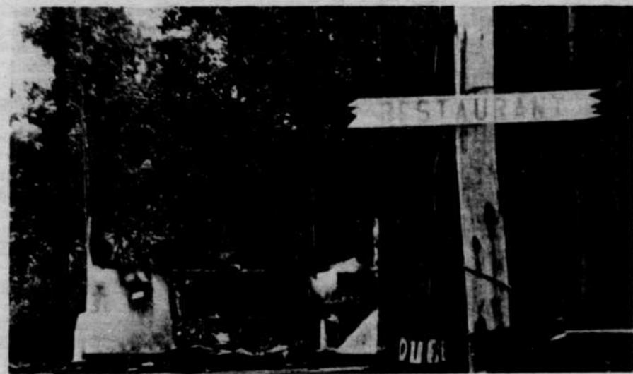
SAINT-NAZAIRE — Le feu a complètement détruit le restaurant de la base de plein air de St-Nazaire il y a quelques jours. La photo nous fait voir ce qu'il en reste. Les pertes sont évaluées à quelque $4,000.
