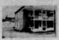
2 logements, situés 72, rue de la Victoire, Chicoutimi-Nord. Cause, départ.
