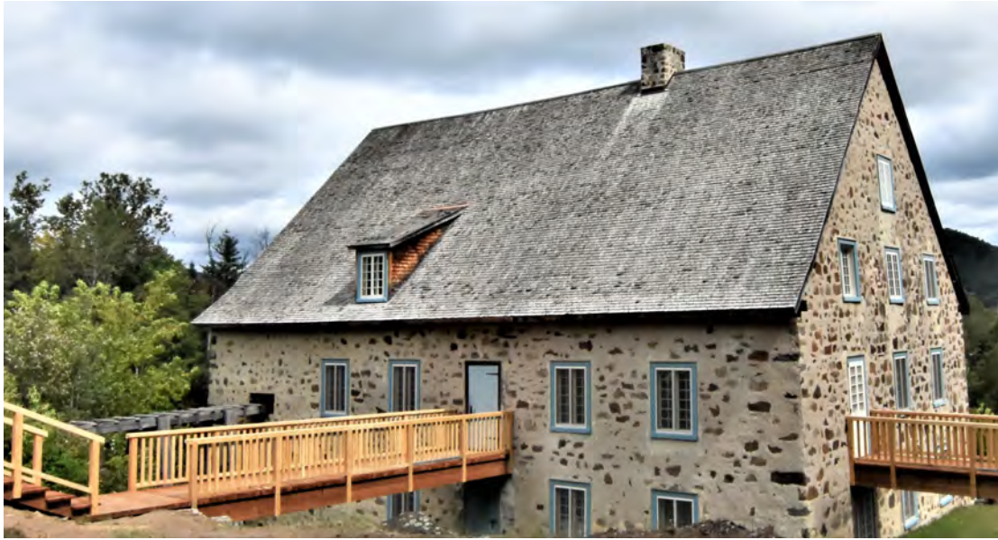
Des passerelles ont été installées pour faciliter les déplacements du public autour du moulin.
