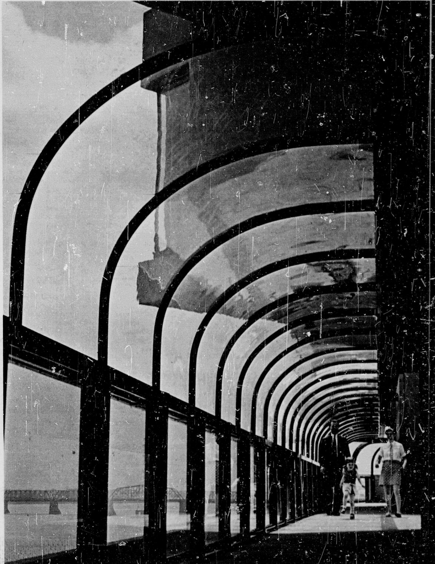
Ci-dessous, ce long corriidor à toit de plastique transparent constitue l'une des trois rues intérieures de l'Habitat 67. ◀
