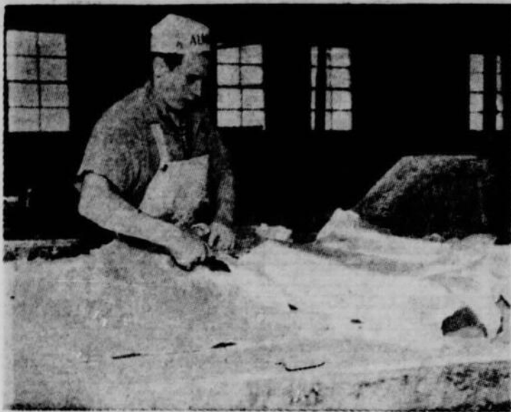
C'est dans un moule comme celui-ci que sont coulées les embarcations en fibre de verre portant la signature de "Princecraft". La coque monopiece résulte d'ingrédients chimiques que l'on verse sur une enveloppe mince semblable à du tissu à vêtements. Ce moule coûte des milliers de dollars.
