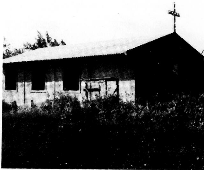
Une petite chapelle qui était en construction dans la région de la Concha.
