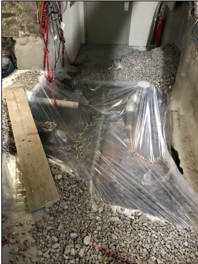
Photo 16 : Sous-opération 13F à la fin des travaux (avant remblaiement).
