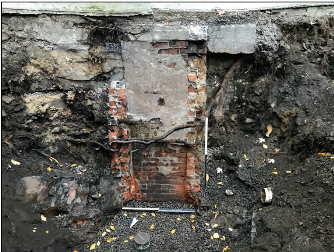
Photo 2 : Ancien égout en briques (13B100) adossé à l'aile des Parloirs, vers le sud. Notez le tuyau en fonte intégré dans l'appareil de briques et partiellement recouvert de crépi de béton.
