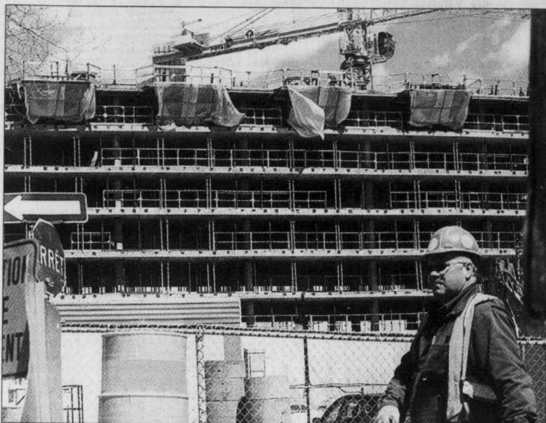
L'îlot Voyageur en construction: l'ensemble des études commandées pour comprendre le boursier financier dans lequel s'est enfoncée l'UQAM coûtera cher à l'établissement d'enseignement.
