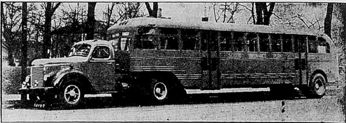
On vient de fabriquer dix autobus de ce genre pour le transport des ouvriers vers les usines de guerre de Marion, Ohio. La carrosserie fut faite par la Wayne Co., à Richmond, Indiana, et la Fruehauf Trailer Company, de Détroit, fabriqua le châssis. Les tracteurs sont fabriqués par la "International Harvester Company".
