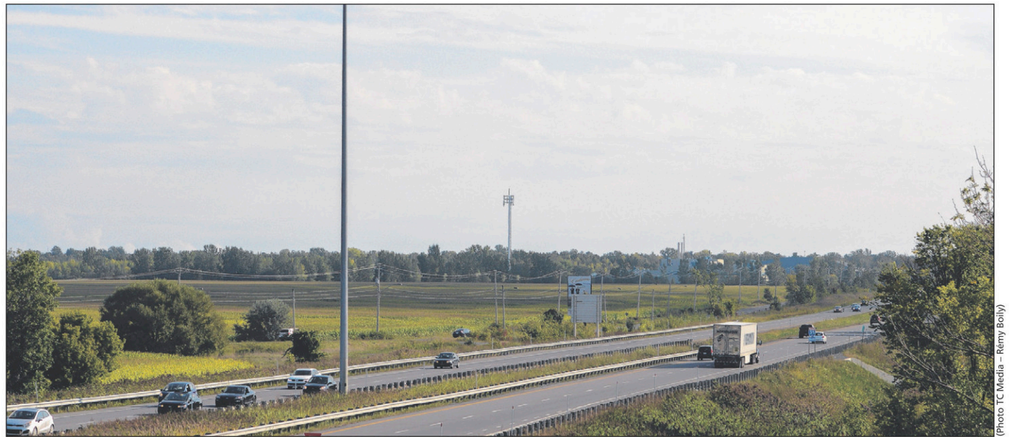
La Ville veut acquérir le terrain situé à l'ouest de l'usine d'épuration, en bordure de la 35, dans le secteur Saint-Luc.
