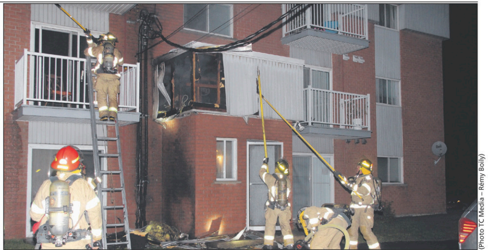
Une vingtaine de locataires ont dû évacuer leur immeuble de la rue Hubert-Paré au milieu de la nuit.
