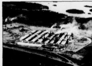
Usine Isle-Maligne Alma
