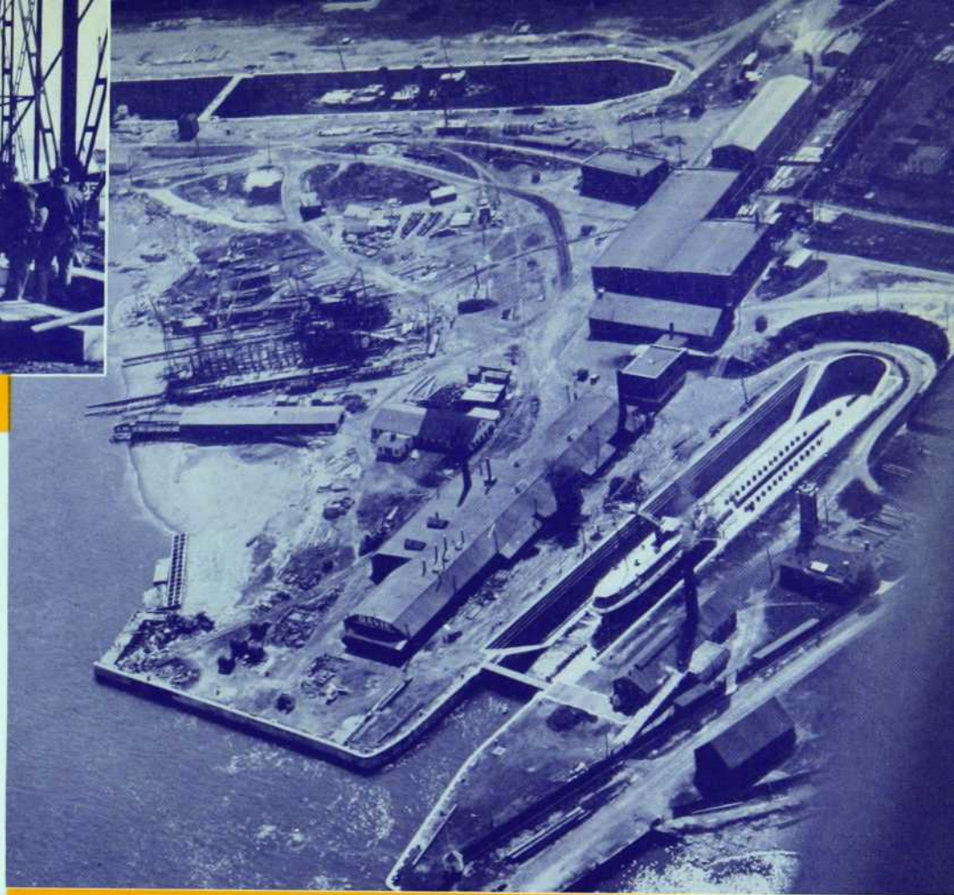
Les fameux chantiers maritimes de la Davie Shipbuilding à Lauzon. Plusieurs grands navires y ont déjà été construits. On aperçoit au premier plan la cale-sèche "Lorne" et, au fond, la cale-sèche "Champlain".
