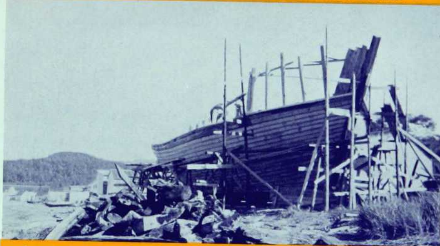
Le "Golfe St-Laurent", un grand navire reconstruit par les frères Verreault, à Méchins, Gaspésie, en 1936. Il existe encore dans le bas St-Laurent quelques chantiers où l'on s'occupe de construction maritime.
