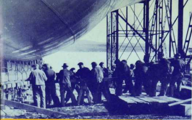
Scène typique dans un chantier moderne.
