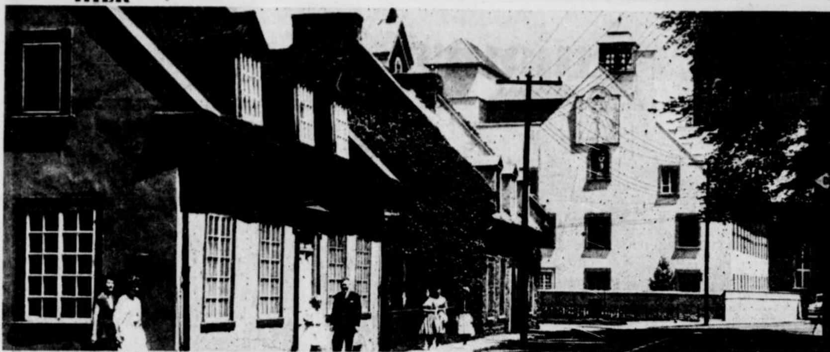
Une vue du vieux Trois-Rivières: au premier plan, la maison Gannes.
