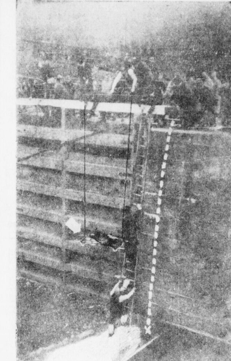
● Les pompiers et les membres de la police locale sont en train de sortir du canal Rideau le jeune Pierre LAROCHELLE, 11 ans, 100, rue Osgoode, qui tomba d'une écluse et se fractura un bras vers la fin de l'après-midi, dimanche. Sur notre photo, la flèche indique le garçonnet couché sur une civière que font monter les pompiers et la ligne pointillée fait voir la trajectoire suivie par l'enfant dans sa chute. (Photo "Le Droit")
