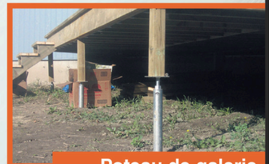
Poteau de galerie
