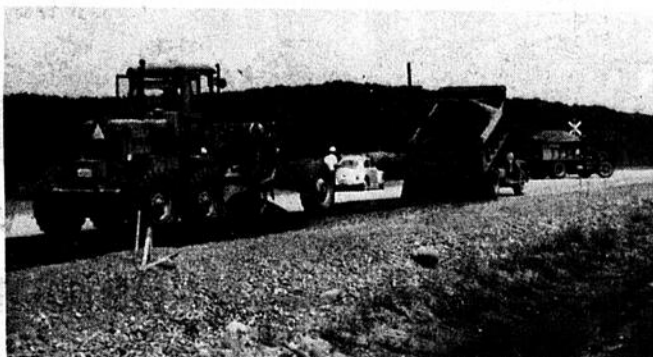
Les travaux se continuent sur la voie de contournement au Sud de Cowansville; la route de gravier est prête à être asphalée.
