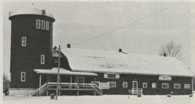
12 décembre 1979 Sous une fine couche de neige la grange et son silo... la suite au printemps 1980.
