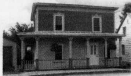
Réalisée grâce au Programme Rénovation Québec. D'autres rénovation sont à venir en 2005.
