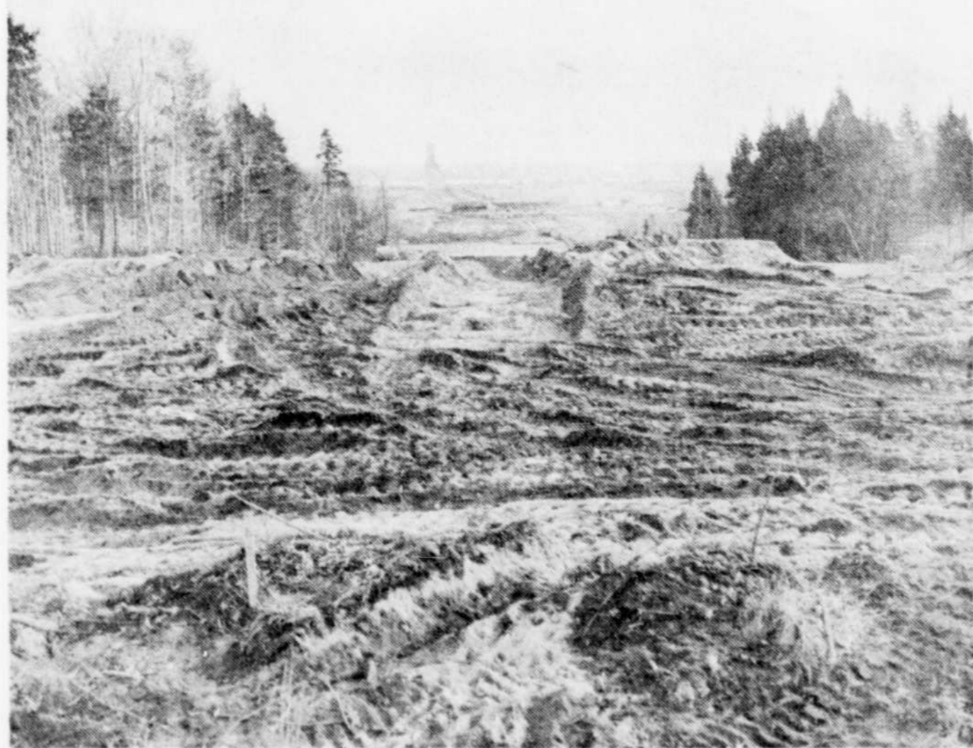
LA COMPAGNIE PAGE CONSTRUCTION, DE TROIS-RIVIERES, procède actuellement à la construction d'un tronçon de la Transquébécoise. Ce premier tronçon débute à la
