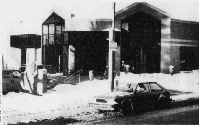
C'est dans ce nouvel édifice que les clients de la Caisse populaire Desjardins de Windsor feront désormais leurs affaires. Les nouveaux locaux de l'institution financière seront accessibles à compter de mardi.
