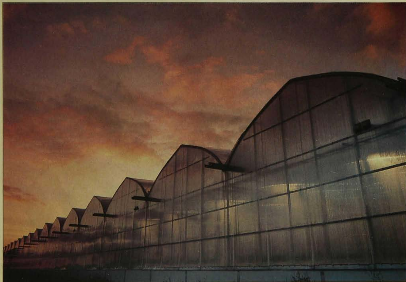
Le complexe serricole Drummond possède déjà plus de deux hectares de serres, et un autre est en construction.
