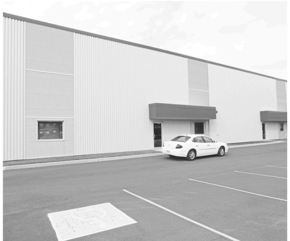
Le Fonds de développement Farnham-Rainville a construit cet immeuble de 9900 pieds carrés en 2012, bâtiment qu'il loue à Distribution Marcel Dion. — PHOTO ALAIN DION
