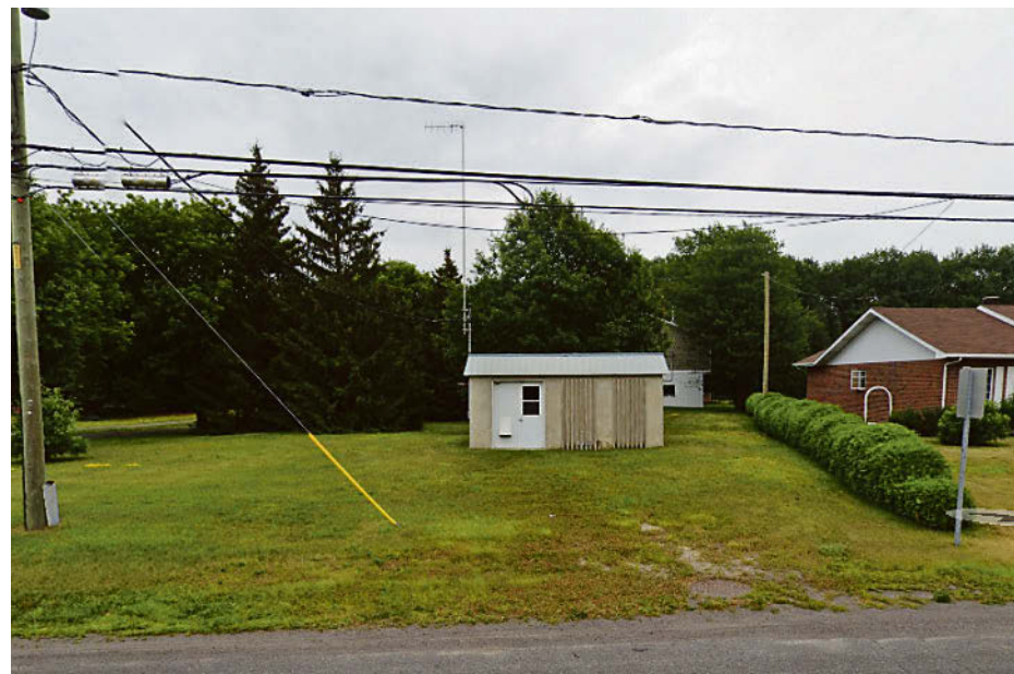
La station de surpression et de chloration de la Régie intermunicipale de l'aqueduc Richelieu-Yamaska située sur le chemin des Patriotes à Sainte-Victoire-de-Sorel nécessitera d'importants investissements en 2024. Photo capture d'écran
