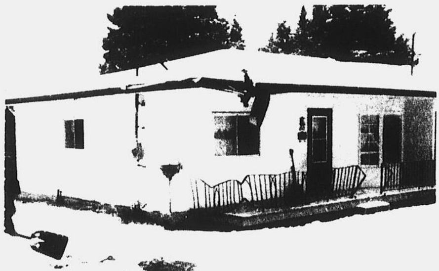
Le camion s'est immobilisé contre cette maison, en causant des dommages à quelques endroits. (Photo l'Écho)
