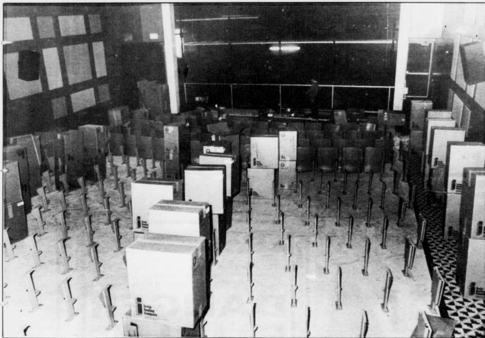
Une des salles du cinéma Fleur de Lys (salle no 5) en cours d'aménagement. Les travaux ont duré environ 8 mois.
