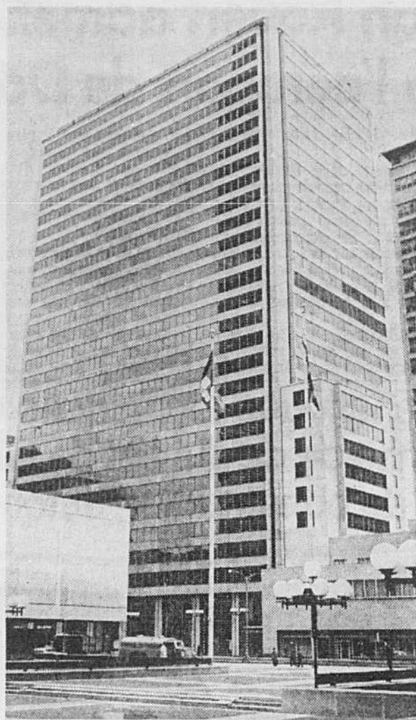
L'édifice Terminal Tower, situé au 800 ouest, boulevard Dorchester, est aussi connu sous le nom d'édifice Celanese.
