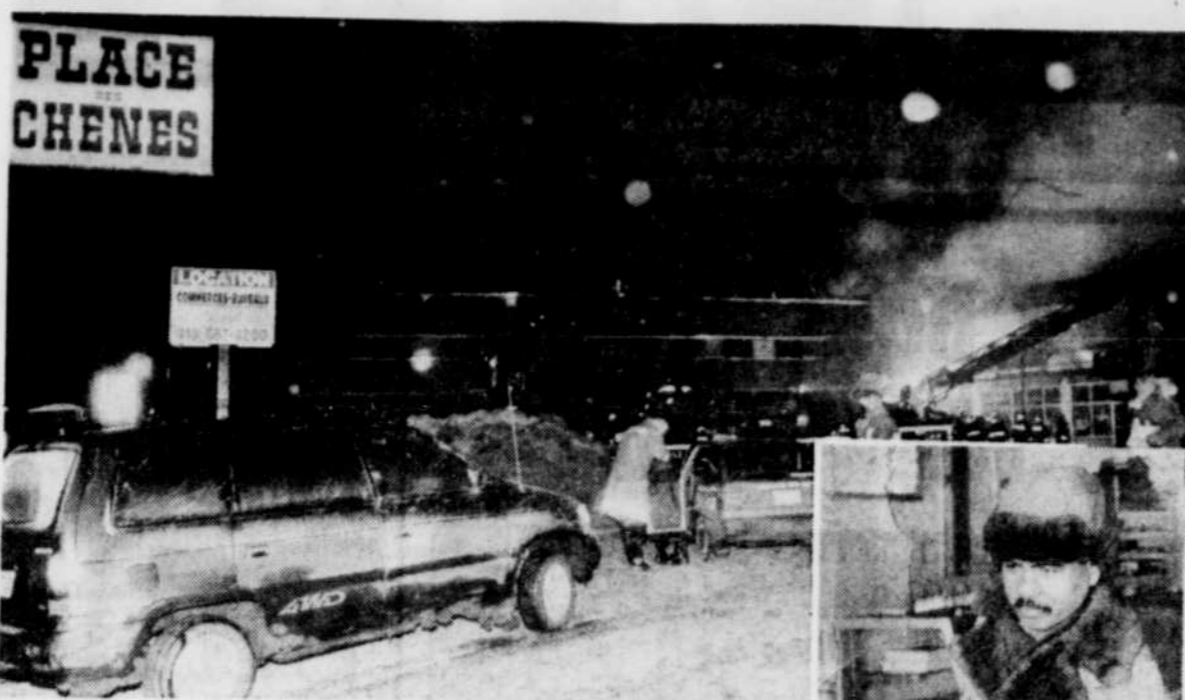
Un incendie criminel allumé dans les locaux du Centre Travail-Québec a ravagé une partie de la Place des Chênes, hier. La pâtisserie de Mao Tum, située au rez-de-chaussée de l'immeuble, est une perte totale.
