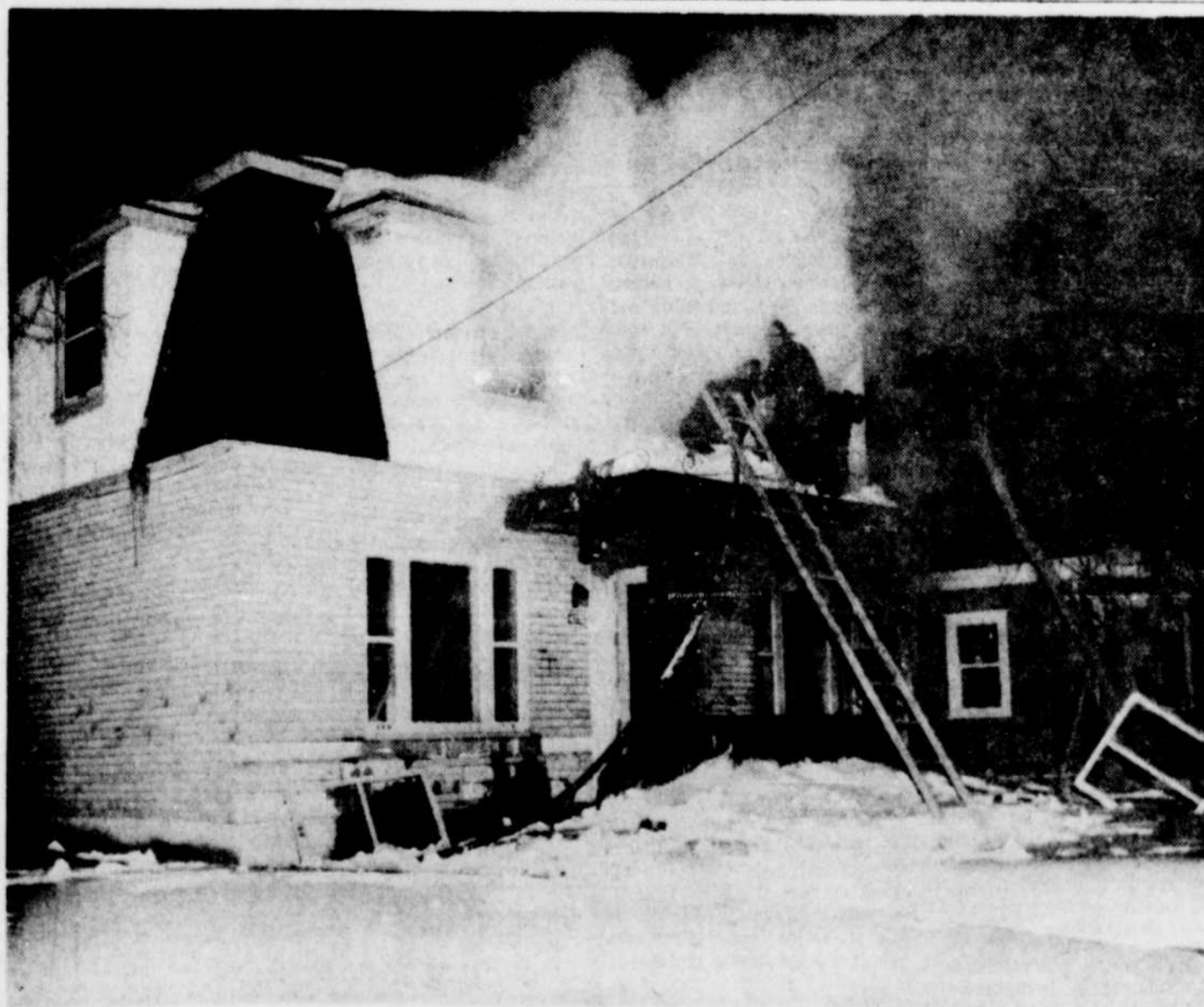
LA DEMEURE de M. et Mme Léo Doucet a fortement été endommagée à la suite d'un incendie qui s'y est déclaré hier soir. Les pompiers des postes un et trois
