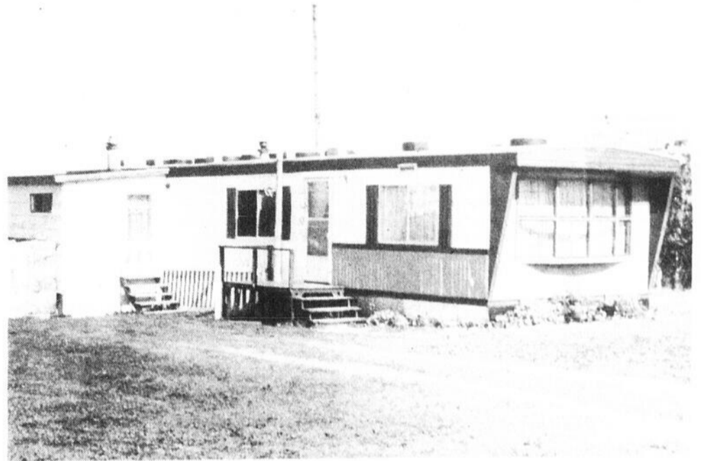
La maison mobile de M. Denis Pelletier où a eu lieu le début d'incendie mais qui n'a causé aucun dommage matériel.
