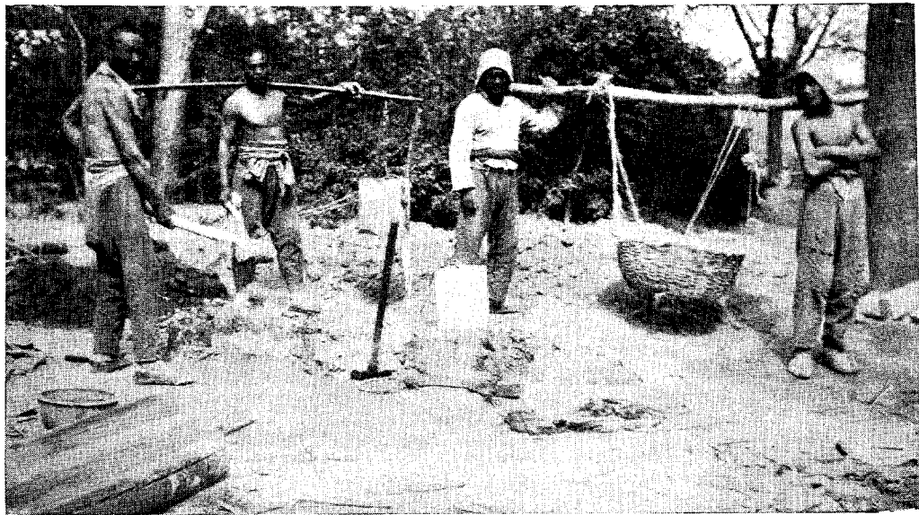
MANŒUVRES PRÉPARANT LE MORTIER
