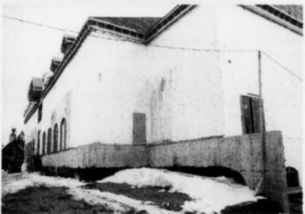
En octobre 2000, l'Hostellerie Les Trois Tilleuls rend public son projet de 3,5 millions de dollars visant à construire un centre de thalassothérapie Givenchy.
