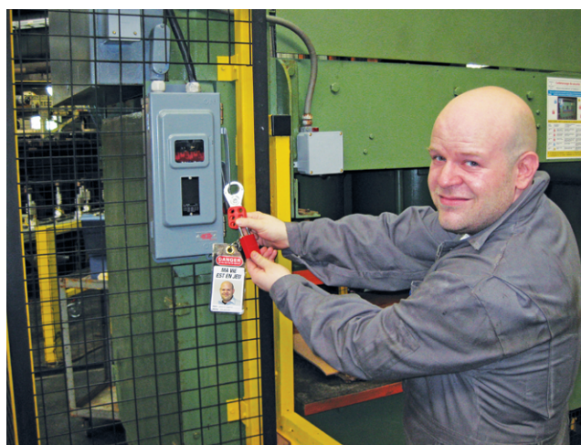
Cadenassage d'une installation électrique
