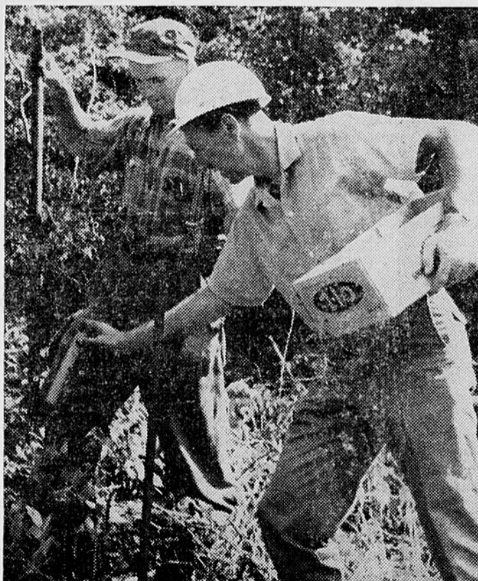
M. Joseph Samson (à gauche) de Val Alain pratique des trous dans le marais tandis que M. Marcel Michaud de la division des explosifs C-I-L à Thetford Mines y place des bâtons d'une demi-livre de dynamitage pour creusage de fossés. La démonstration du creusage de fossés à l'aide de dynamite fut faite récemment sur la ferme de M. Philippe Champagne près de Ste-Agathe de Lotbinière.
