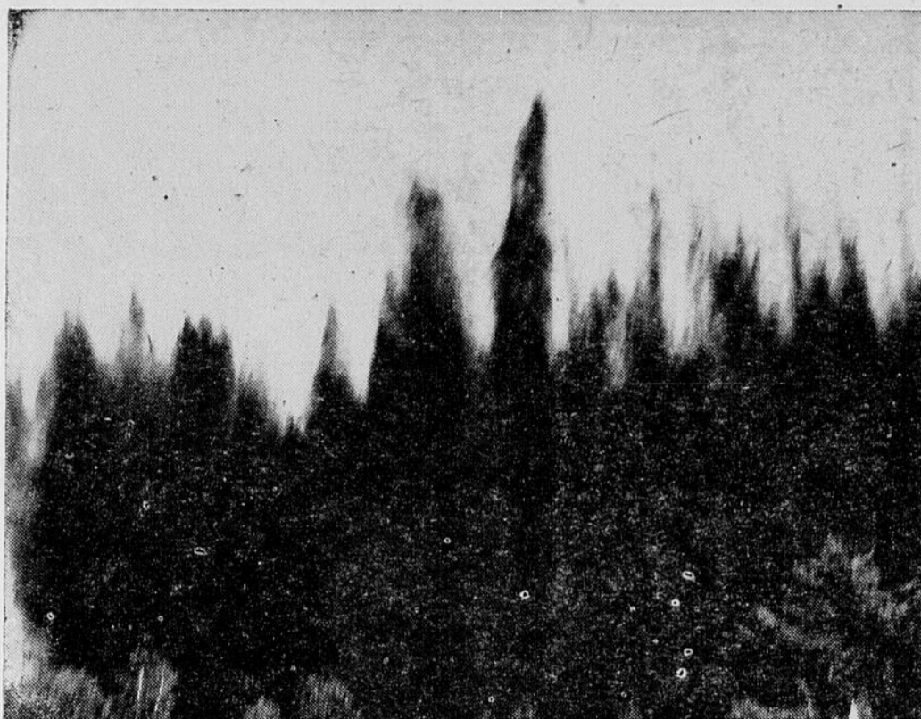
Champagne, lors d'une démonstration de creusage de fossés à l'aide de dynamite. Ce jet de bouement 200 fermiers des environs de Ste-Agathe de Lotbinière. La décharge d'une explosion qui Ste-Agathe de Lotbinière. La décharge d'une explosion qui Ste-Agathe de Lotbinière. La décharge d'une explosion qui Ste-Agathe de Lotbinière.
