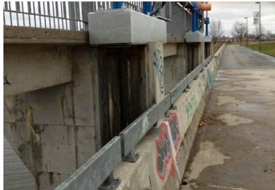
Figure 3.9: Point d'échantillonnage au barrage ou sortie du réservoir Beaudet
