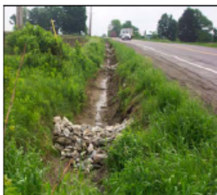
Figure 5.3: Berme et enrochement dans les fossés et ruisseaux
