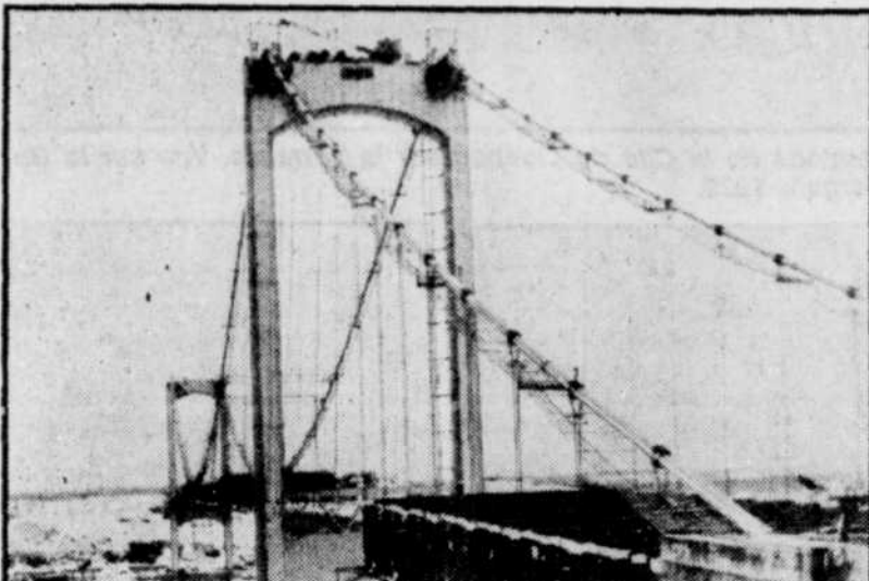
La construction du pont Pierre-Laporte qui fut inauguré le 6 novembre 1970.
